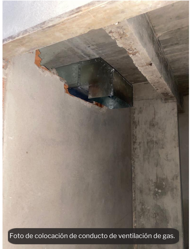
Foto de colocación de conducto de ventilación de gas.
