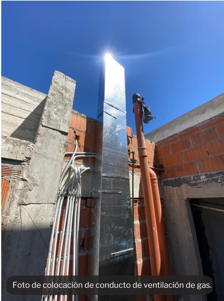
Foto de colocación de conducto de ventilación de gas.
